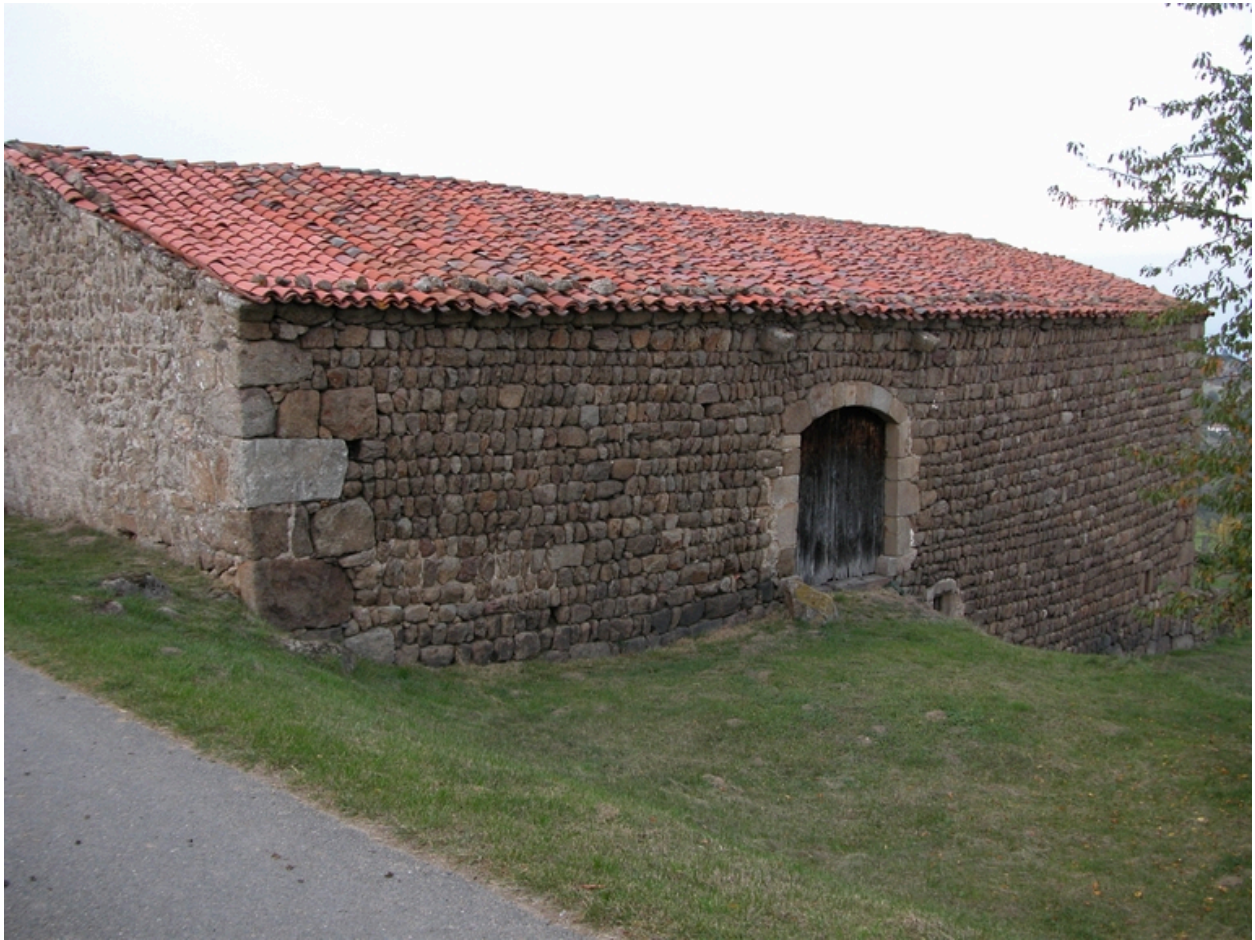
Vue arrière de la grange-étable.
