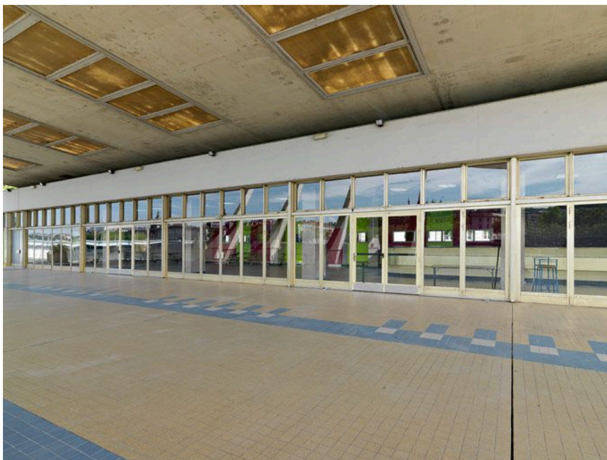
Vue de la terrasse et du bar (niveau du quai, état en juin 2012).
