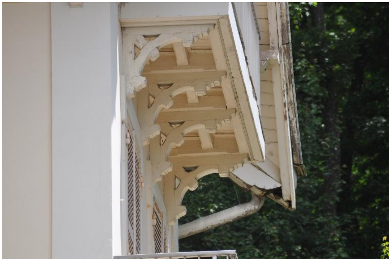
Aisseliers en bois supportant un balcon
