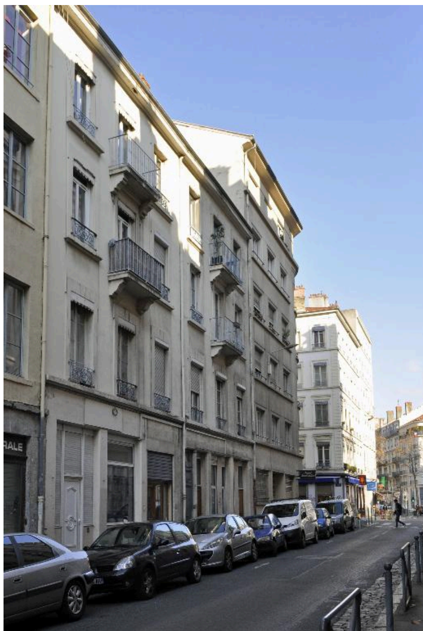
Elévation sur rue, vue d'ensemble
