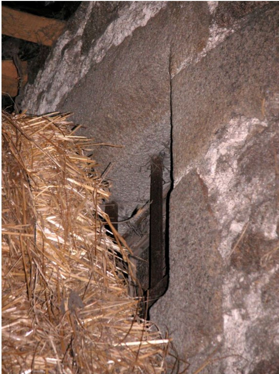
Détail d'une baie extérieure de la tour d'escalier hors-oeuvre.
