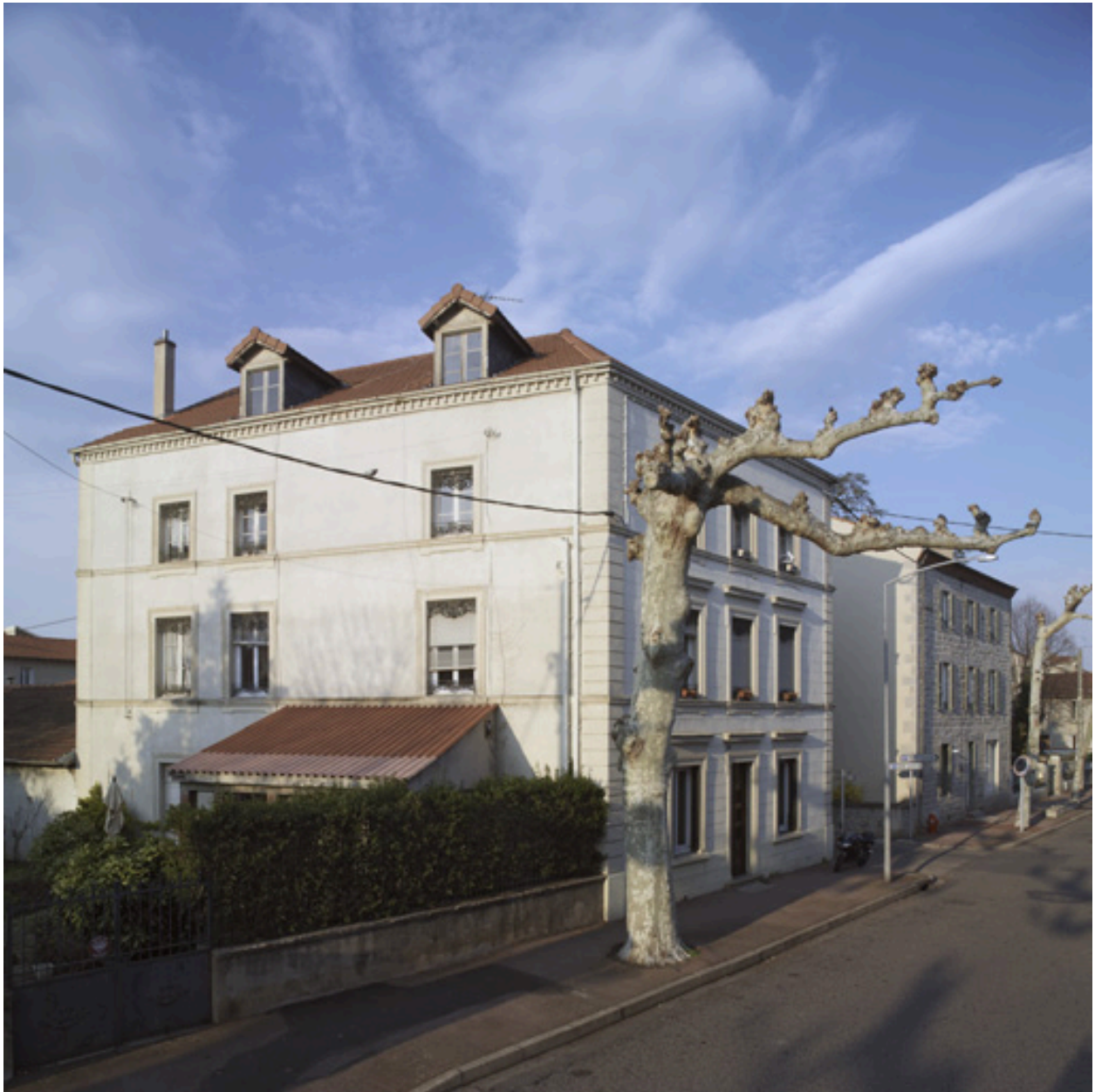
Immeubles le long de l'avenue d'Alsace-Lorraine, n° 15-17.
