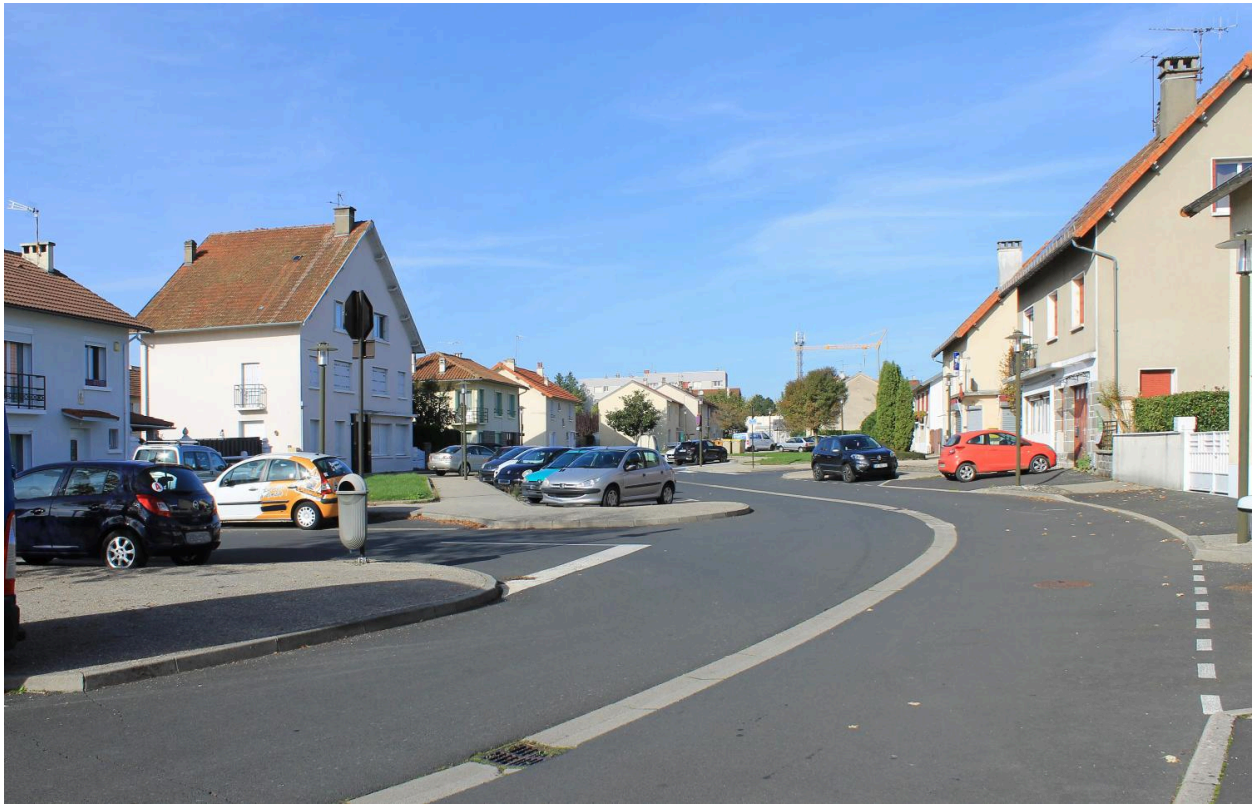
Aurillac, cité des Camisières, la « place centrale » vue du sud, depuis la rue de la Truyère.
