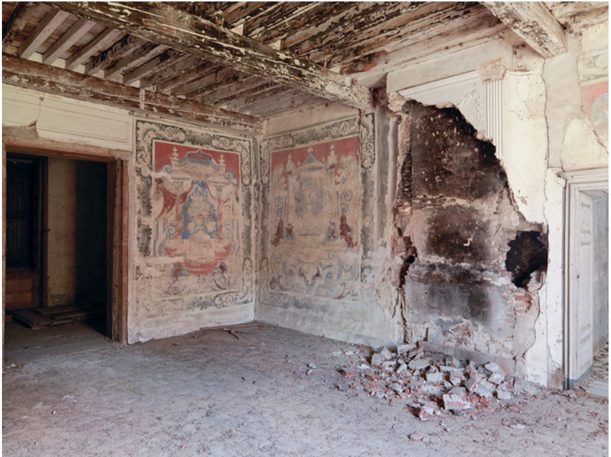
Angle sud-est : vue du panneau à droite de la porte d'entrée et du panneau à gauche de la cheminée.
