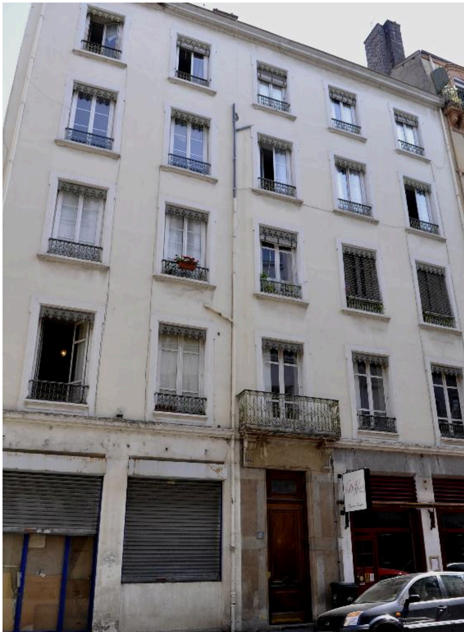
Vue générale de l'élévation sur rue
