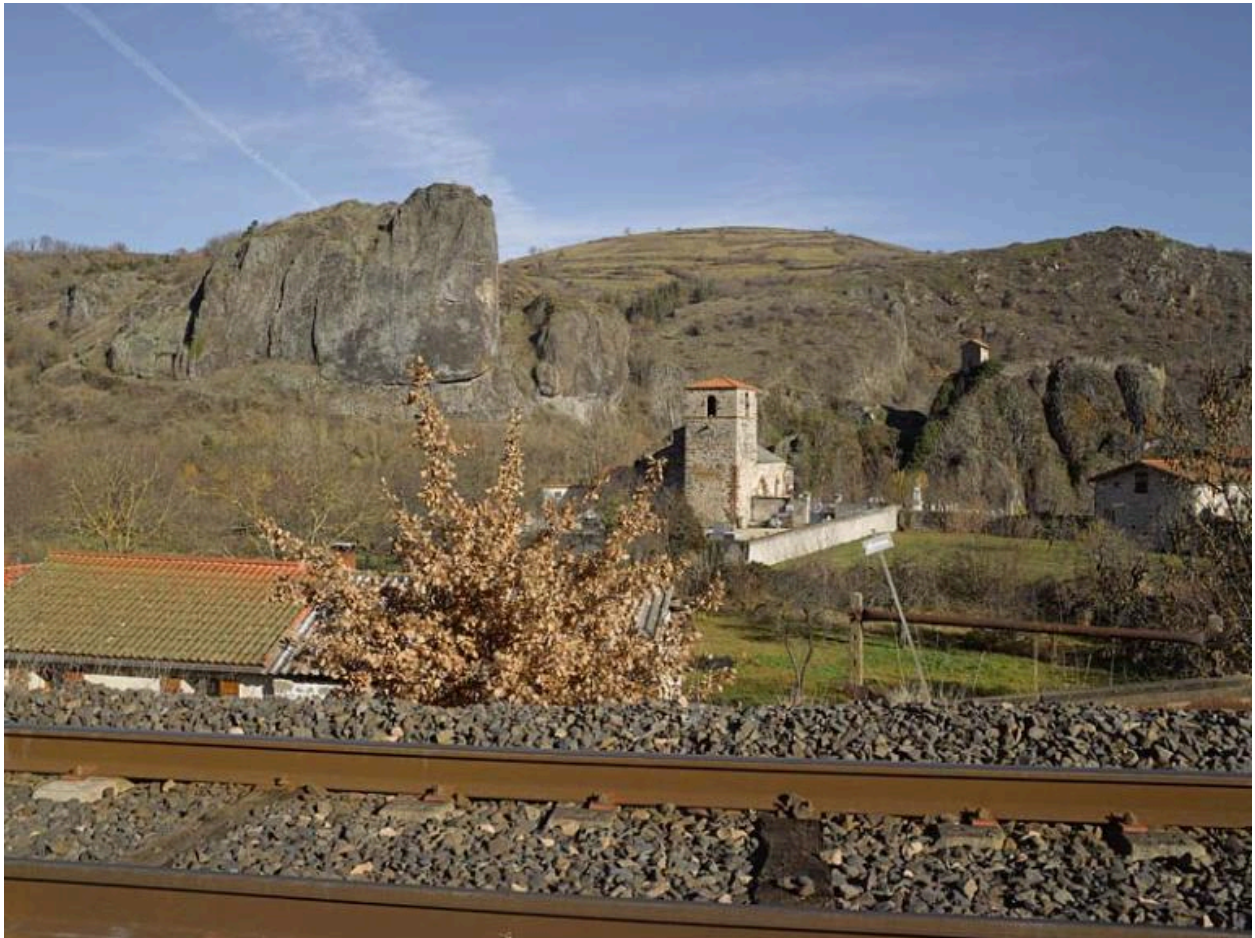
A gauche, vue de la roche Servièrre à proximité de Prades, depuis la voie ferrée.
