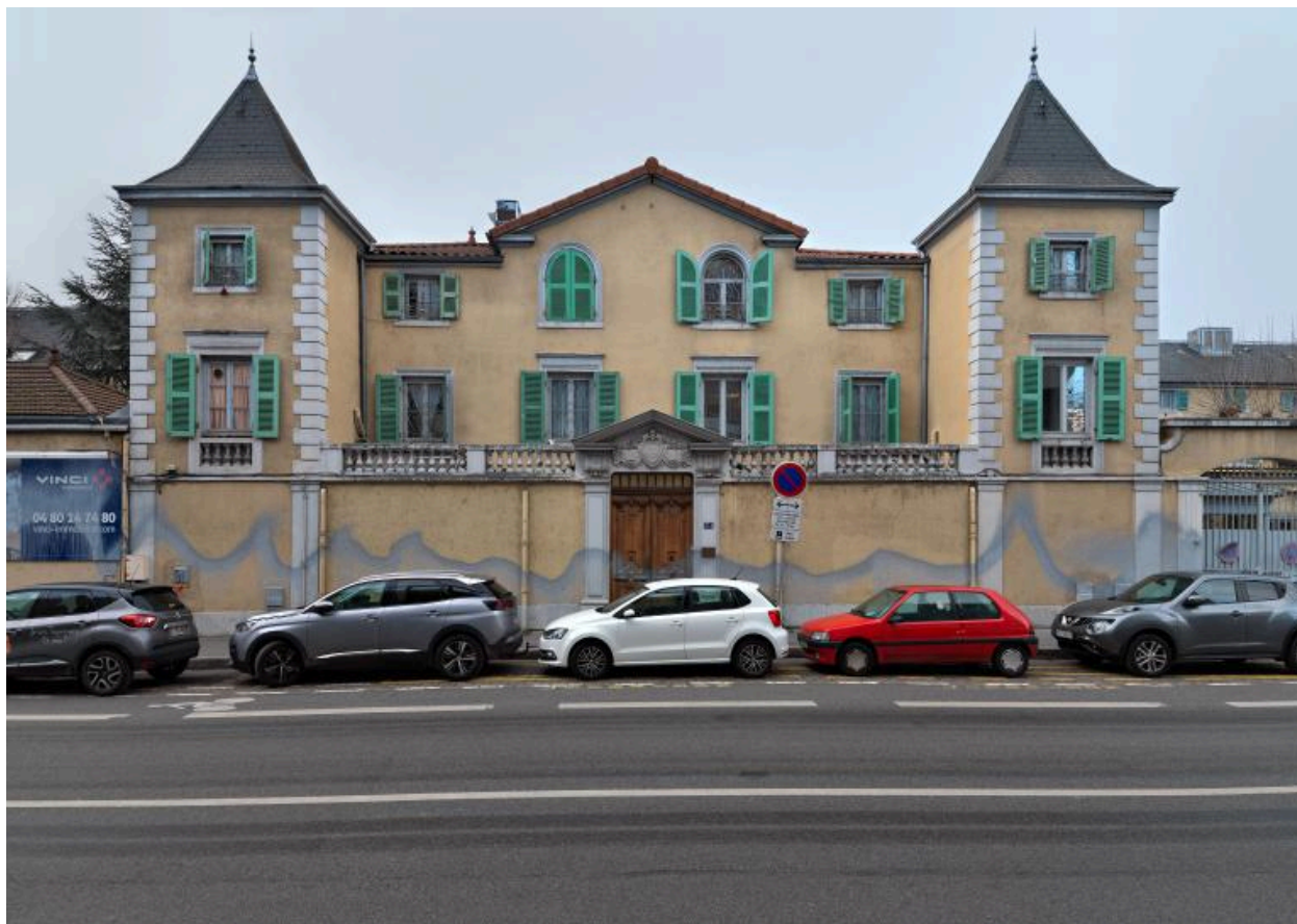
Bâtiment central, élévation sur rue, vue de l'est
