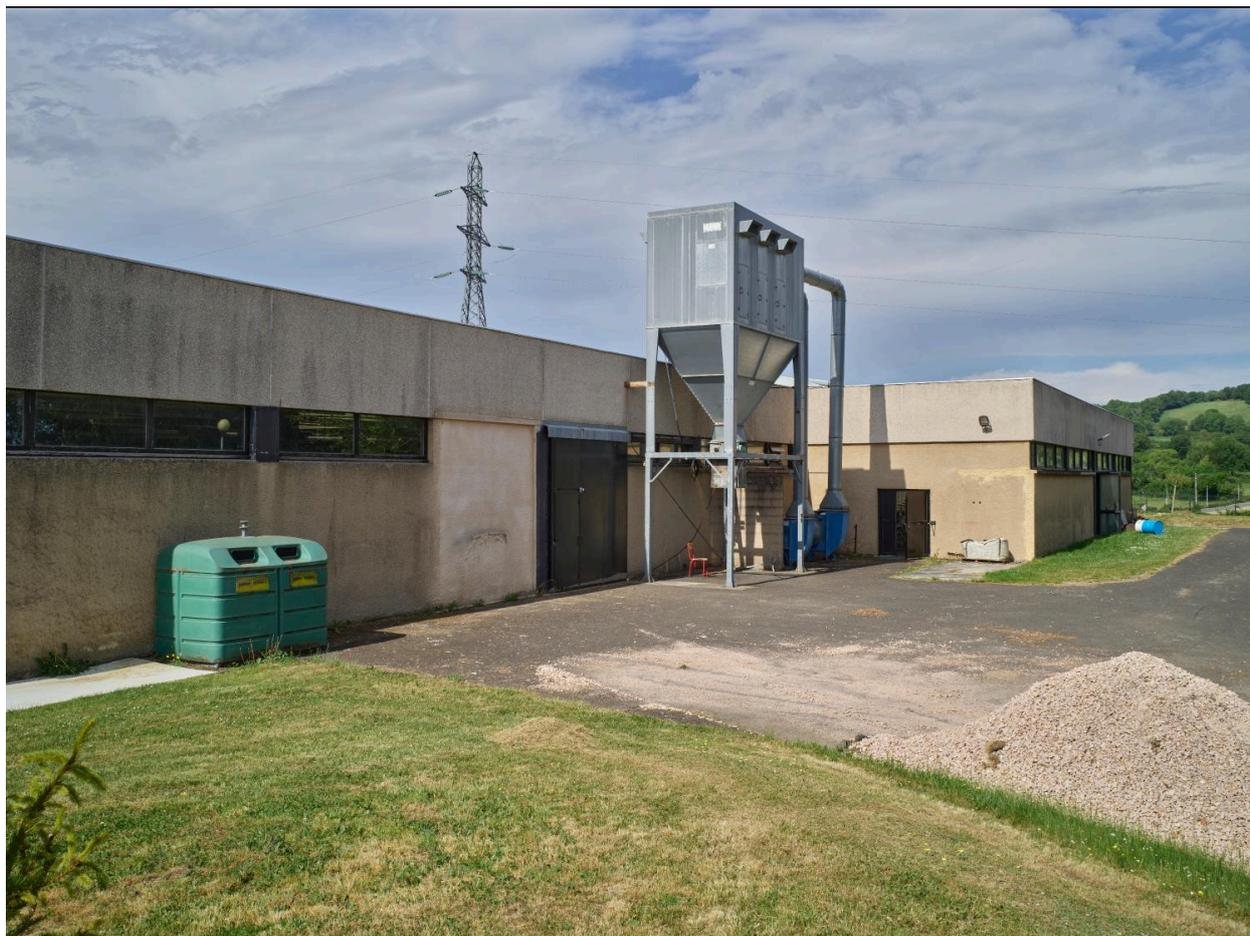
Bâtiment des ateliers, élévation nord. La structure métallique correspond à une "filtration" de la menuiserie en vue de la récupération des copeaux de bois, et à un aspirateur des poussières fines.
