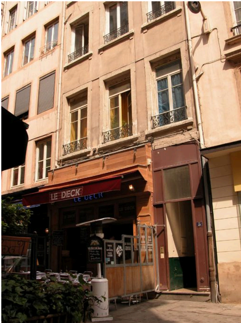
Élévation antérieure : rez-de-chaussée et premier étage carré
