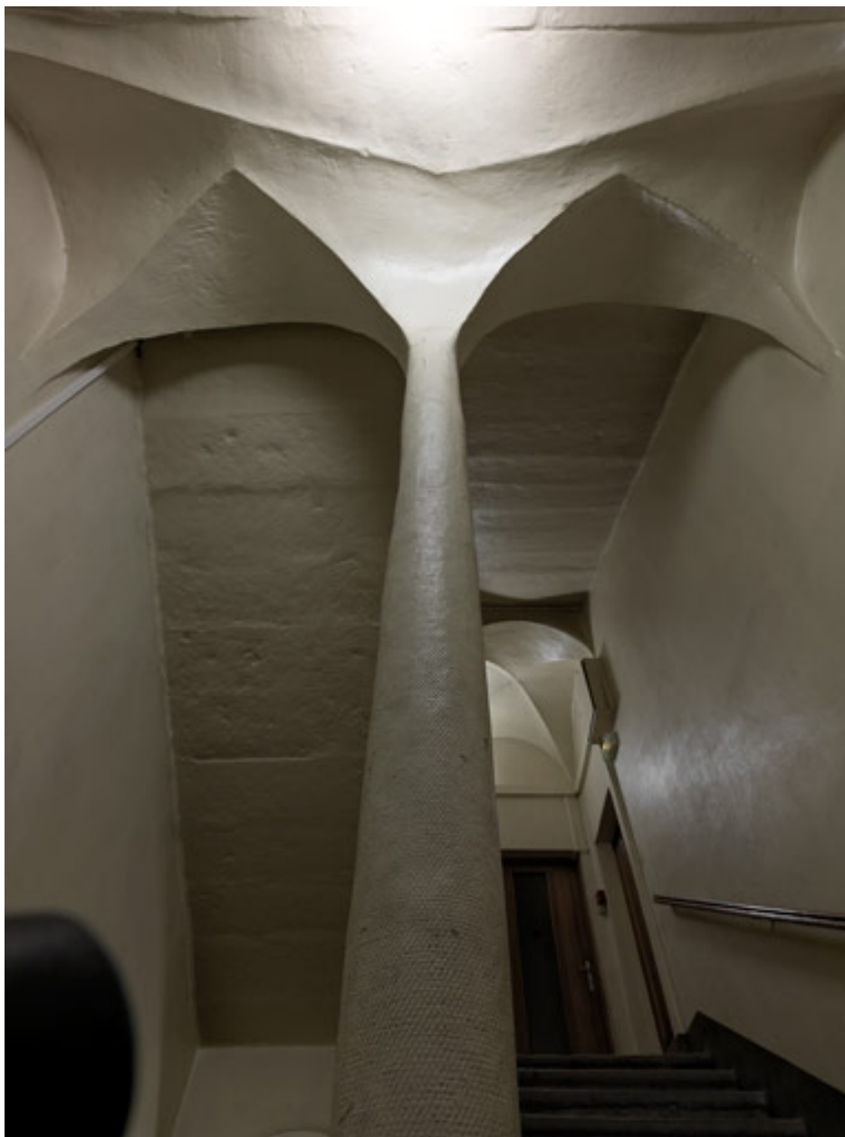
Bâtiment S nord. Escalier dit de la Cloche depuis le palier du 1er étage
