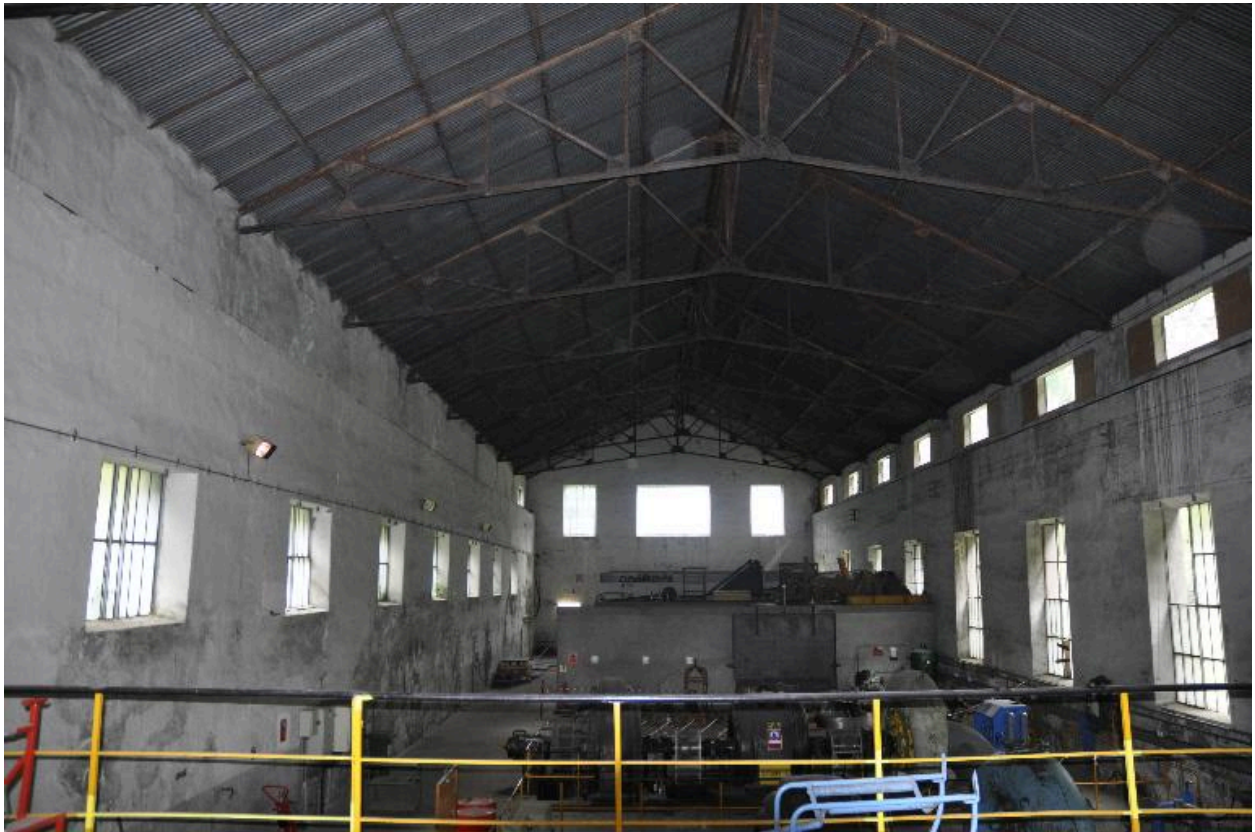
Vue de la charpente métallique à entrants brisés de Pierre-Eybesse II
