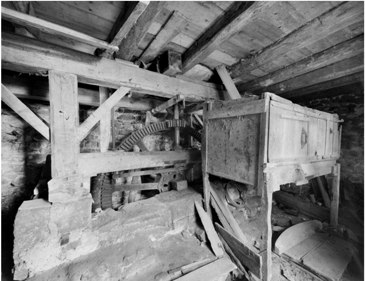
Rez-de-chaussée surélevé, vue d'ensemble du blutoir.
