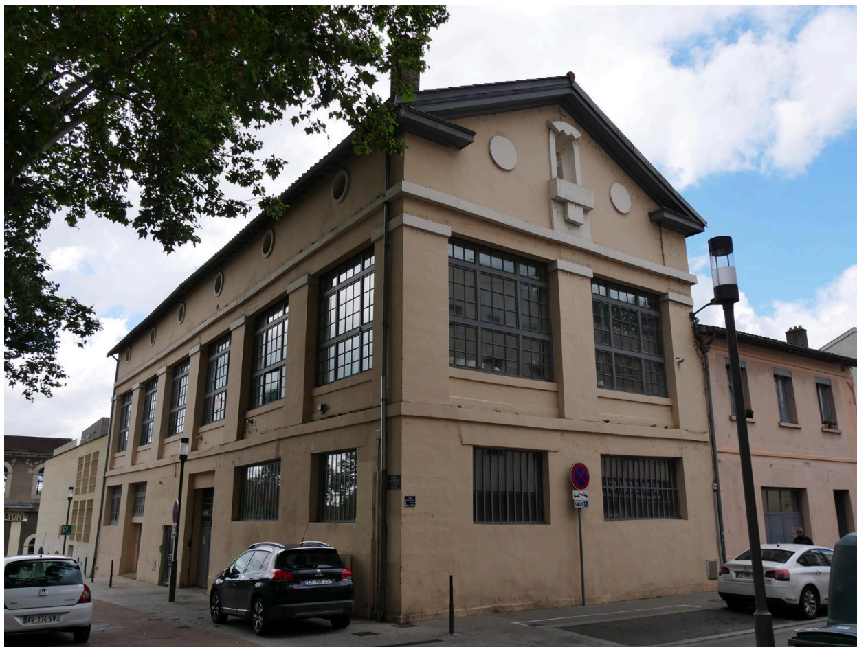
Verrerie Berticat vue nord
