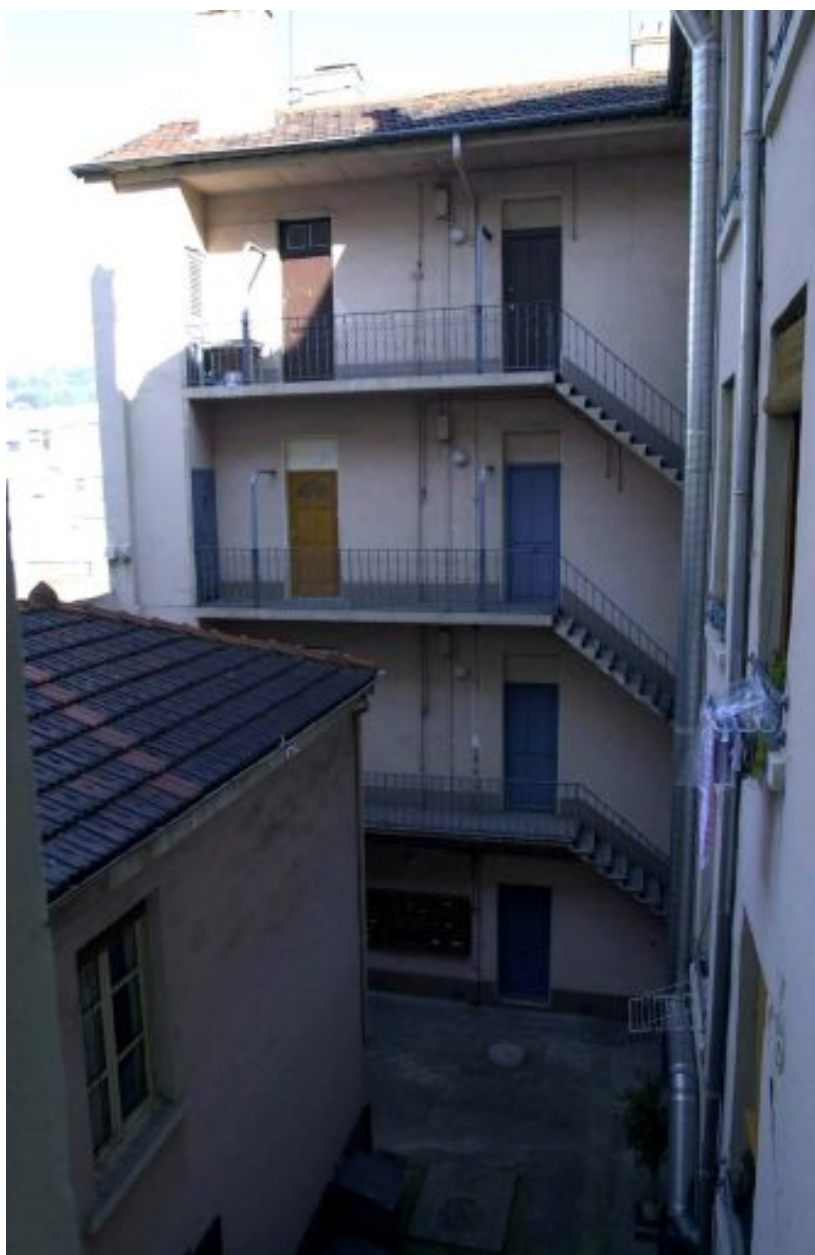
Vue des coursières de l'immeuble sur rue
