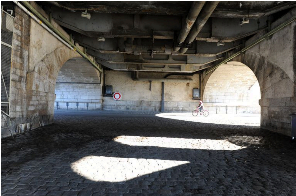
Travée de rive gauche, de dessous, vue générale (depuis la rive gauche)
