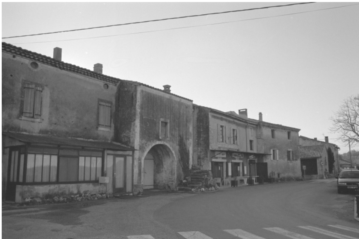
Alignement de façades au centre du village, bordant le côté sud de la R.D. 56, parmi lesquelles celle du bar-tabac, et le lavoir couvert au fond, à droite.
