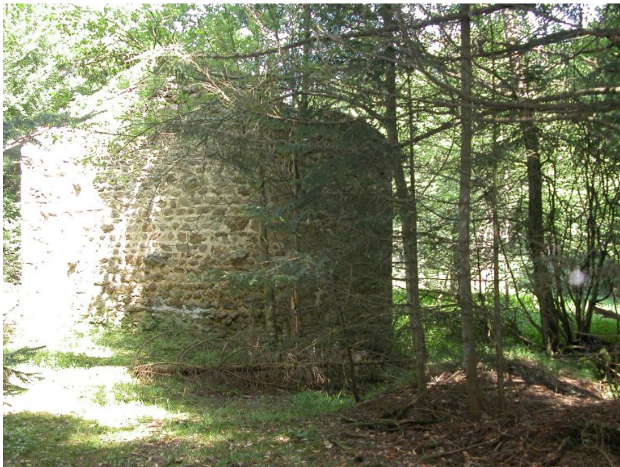
Vue d'ensemble du mur pignon ouest.
