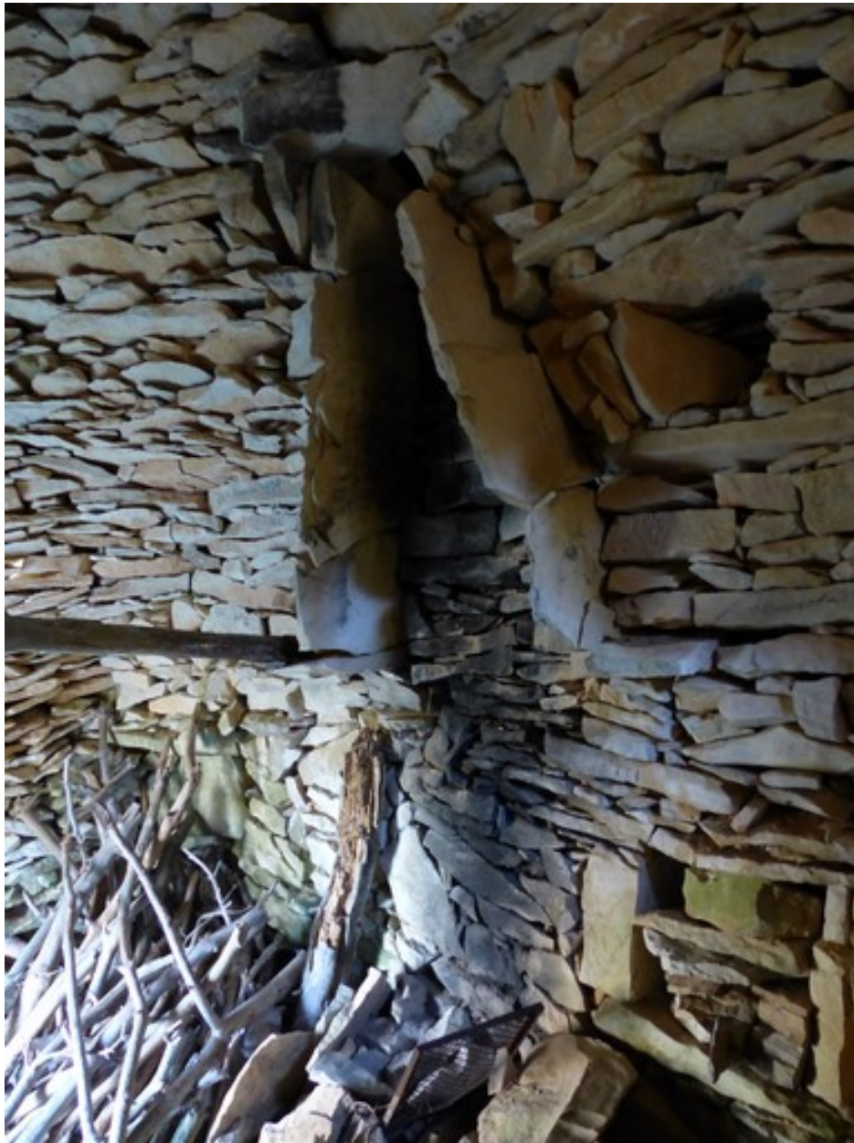
Cabane nord. Mur sud, cheminée.
