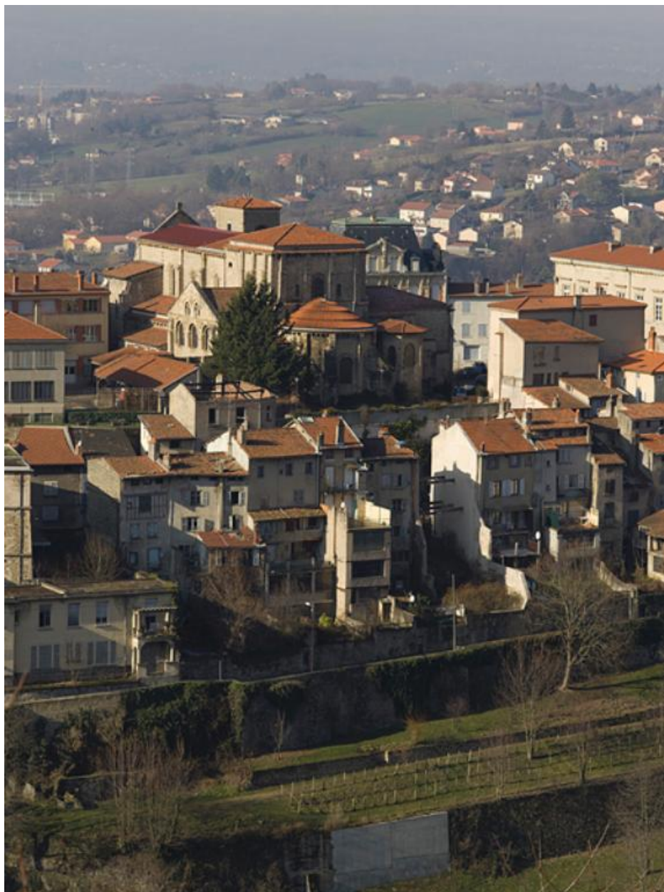
L'église au coeur du quartier Saint-Genès, depuis l'est.
