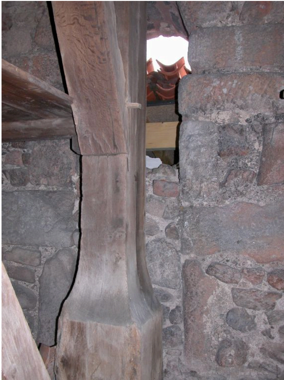
Détail de poteau de la chambre de cloches.
