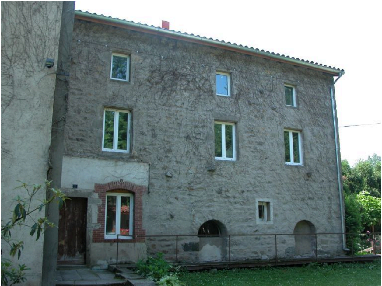
Élévation du second corps de bâtiment, façade nord-ouest du moulin.
