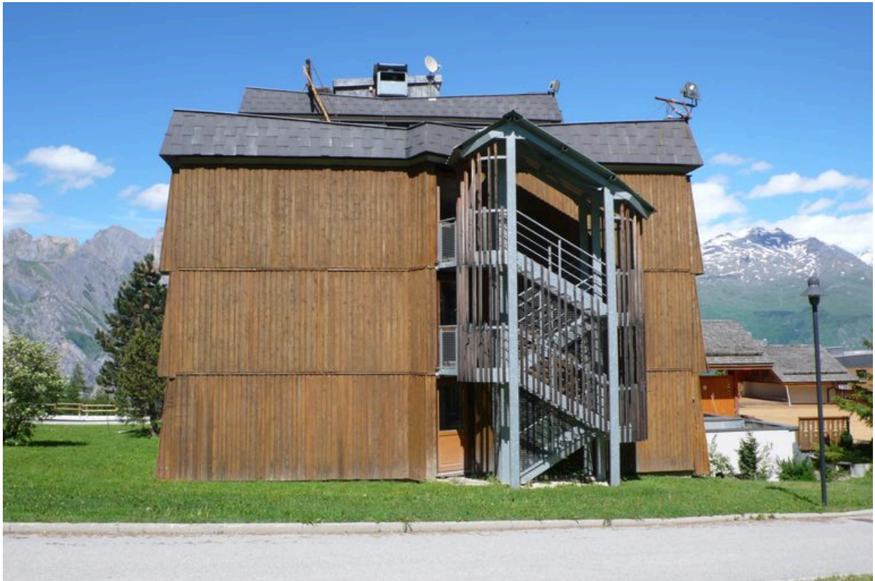
Elévation latérale. Escalier de secours rapporté
