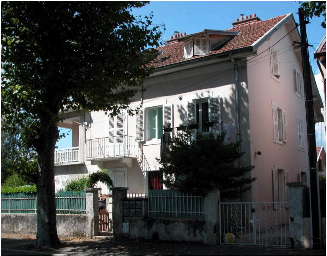
Façade principale (sud) et pignon est
