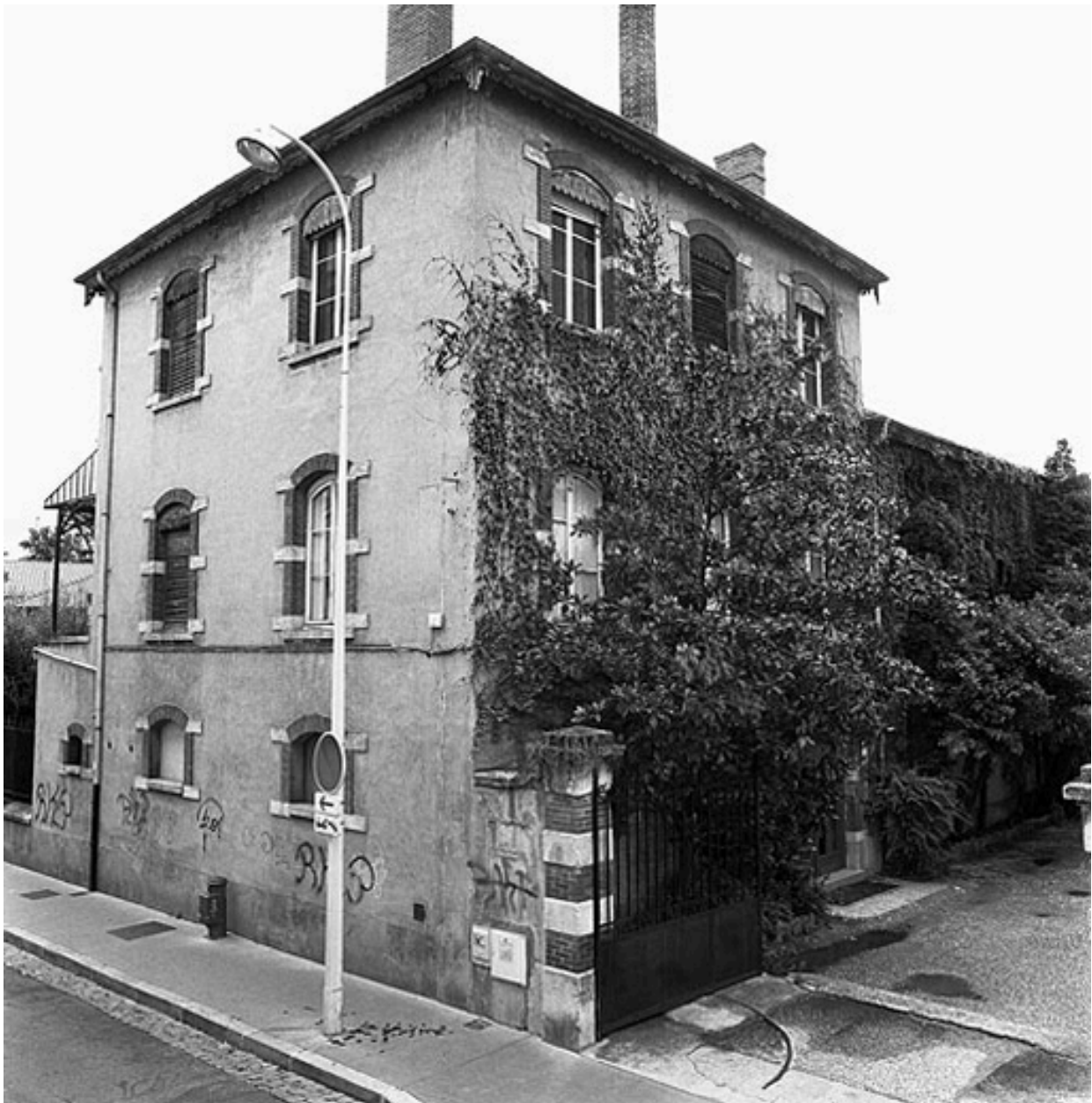
Entrée principale des ateliers Prella
