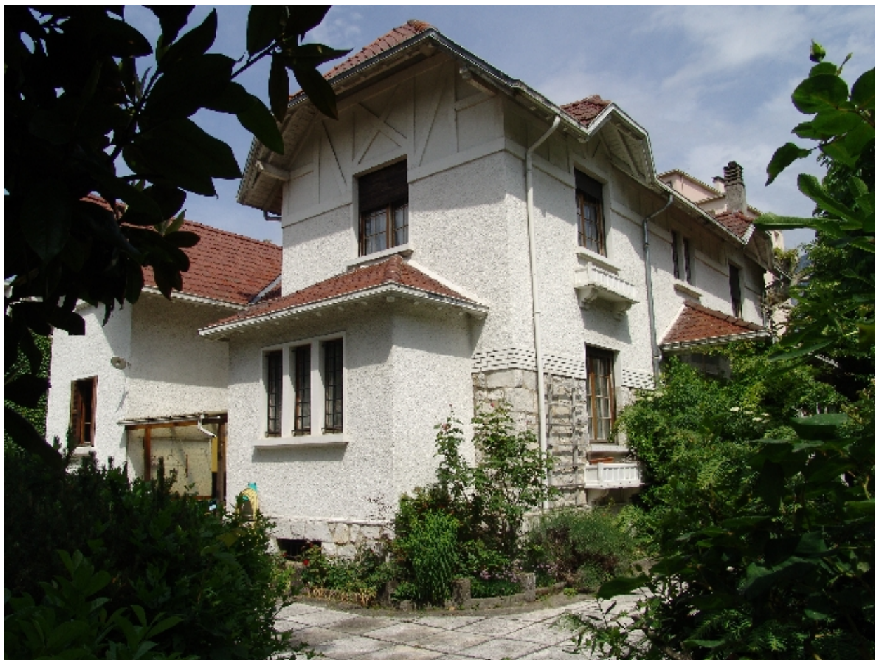
Façades postérieure et latérale gauche
