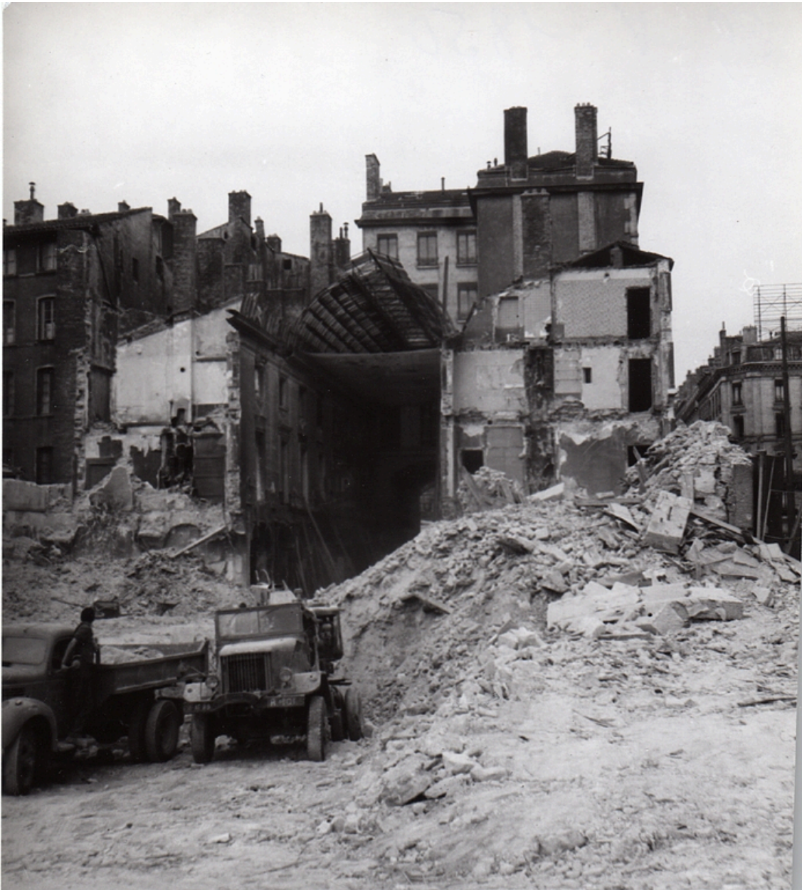
Démolition du passage, élévations intérieures et verrière
