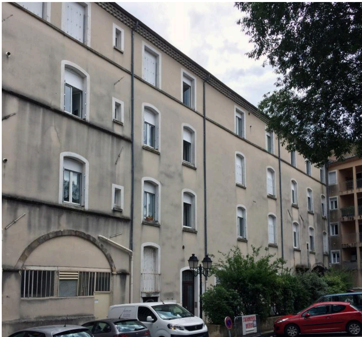
Vue depuis le nord de l'ancienne élévation nord sur cour
