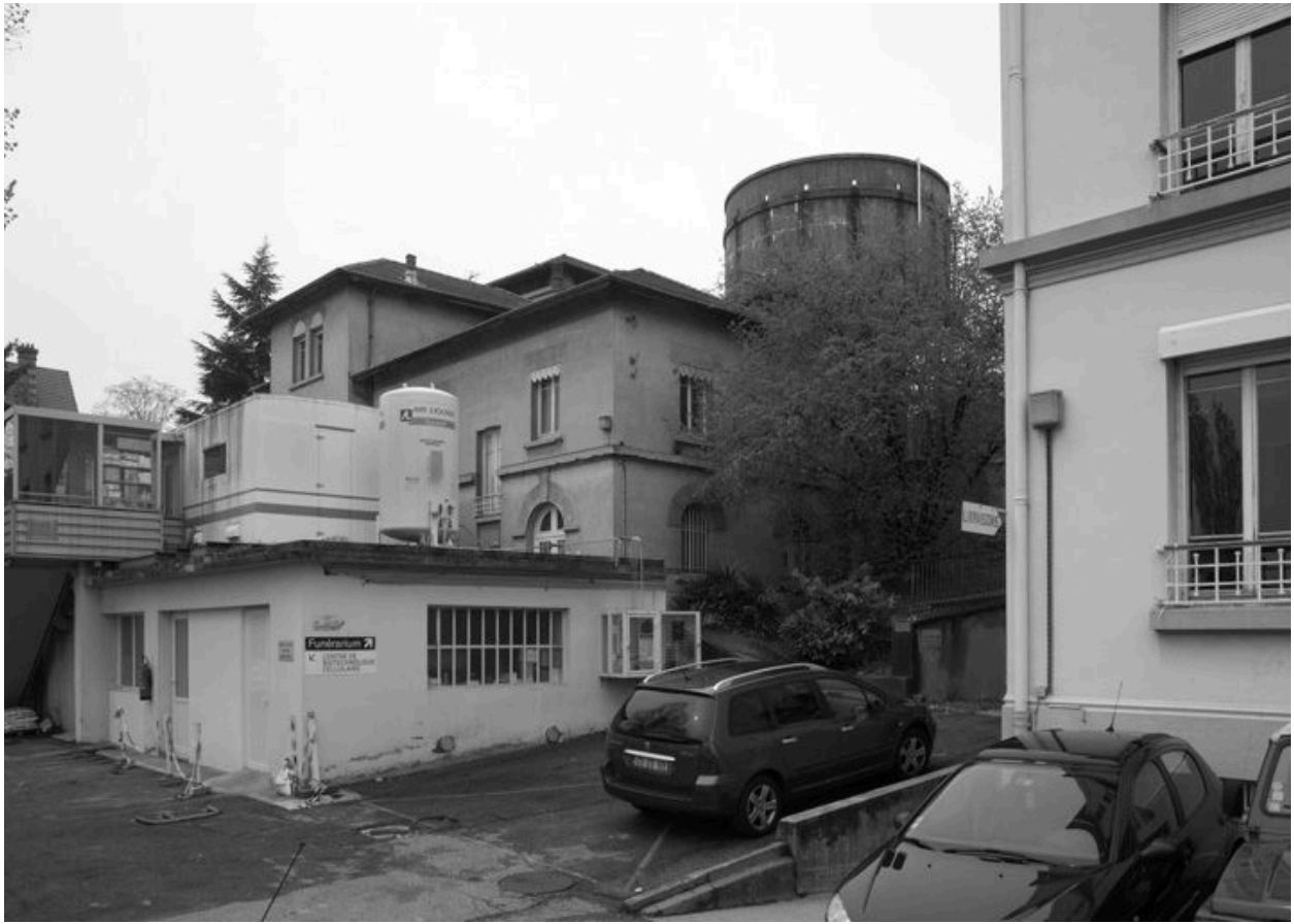
Bâtiment 8 au premier plan, Bâtiment 9-10 au second plan, façade est
