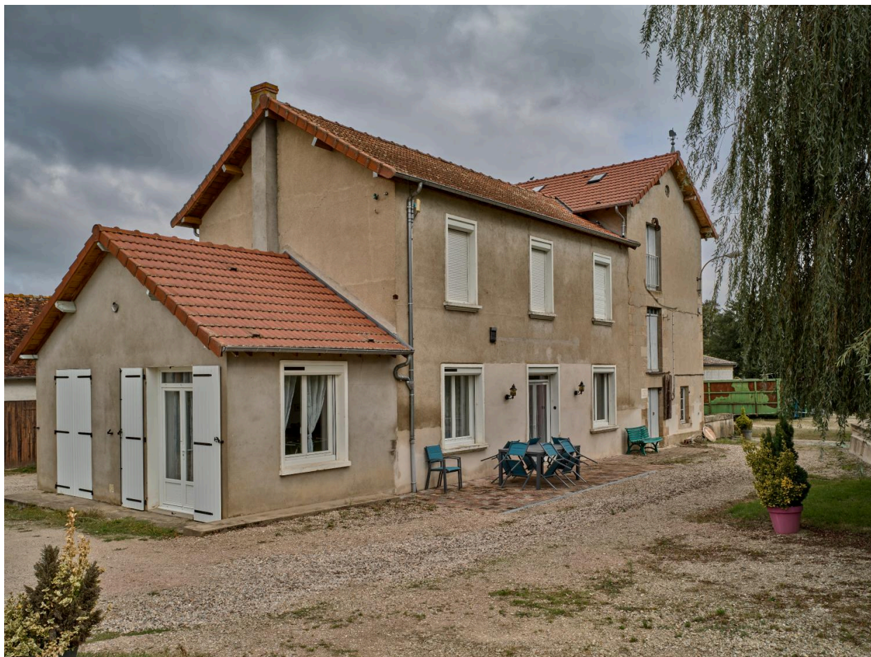
Vue du sud-est du moulin
