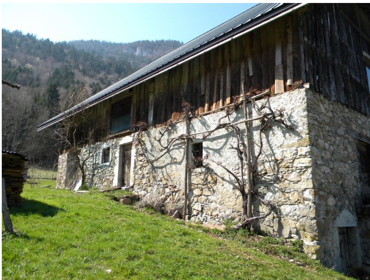
Vue du mur gouttereau sud-est.
