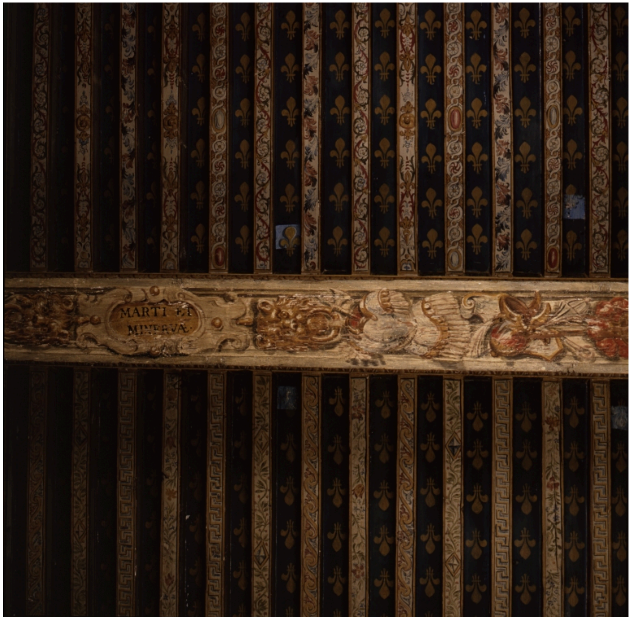
Poutre 3, face inférieure, centre et partie droite : cartouche à Mars et à Minerve, trophées d'armes.
