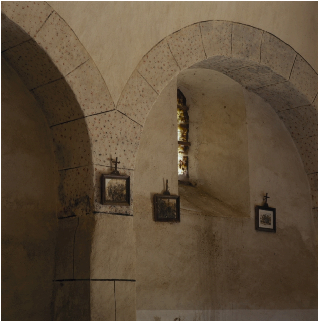
Détail des arcs formerets dans la nef, mur sud.
