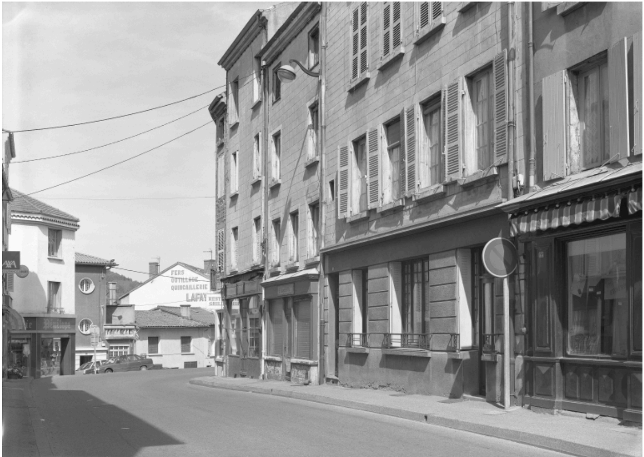
Vue de la rue de Clermont et du carrefour des rues Gustave Labrosse et Philippe Raymond au fond, de l'est.
