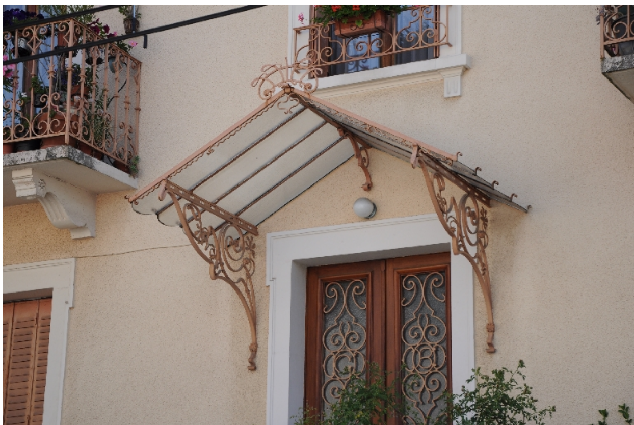
Détail sur la marquise de l'entrée
