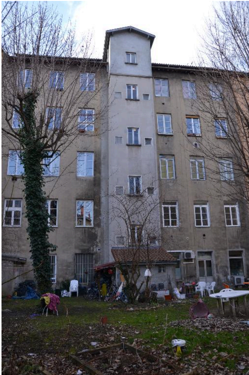
Vue d'ensemble façade nord
