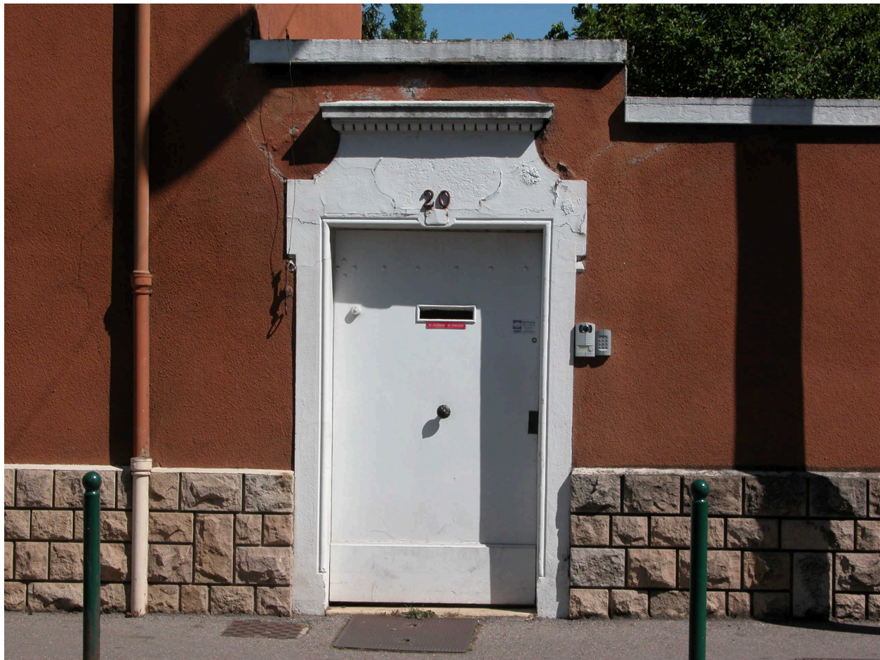
Vue de détail de la façade sud, porte d'entrée
