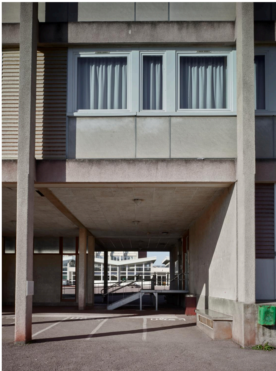
Bâtiment B. Détail du préau, ici traversant.
