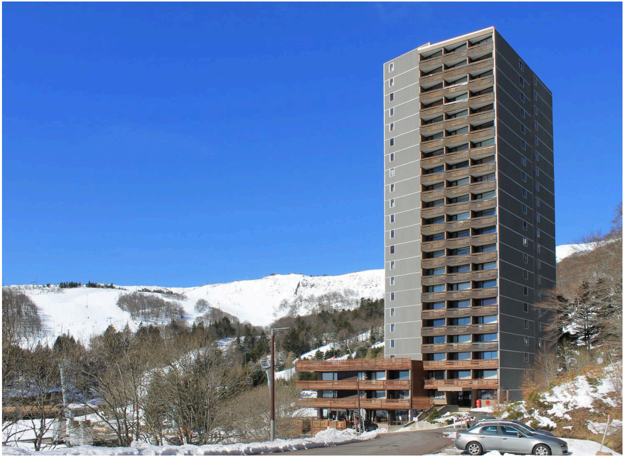
Super-Besse, la Tour de la Biche vue de l'est (façade principale sud-est et façade latérale nord-est).
