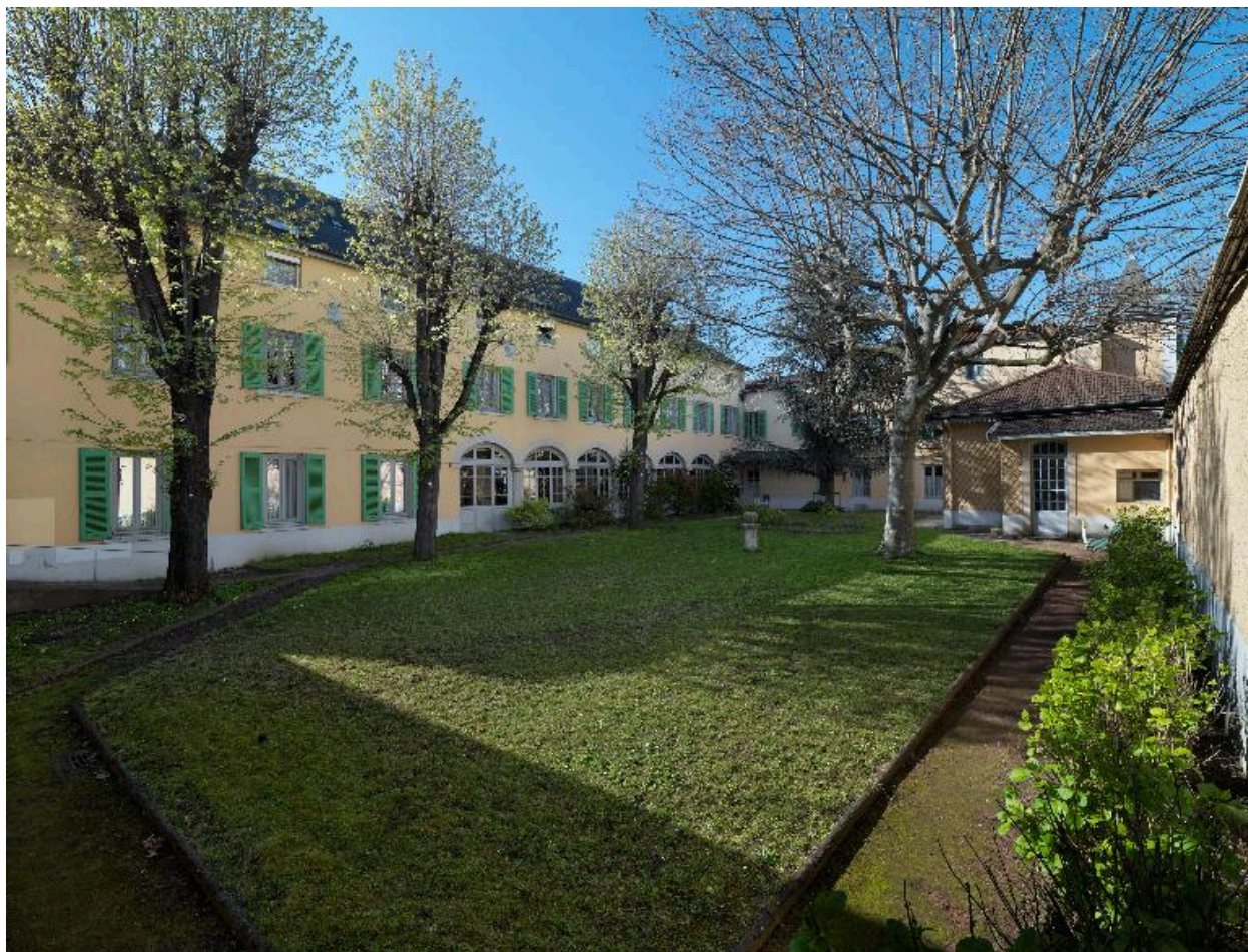
Cour sud-est, vue générale
