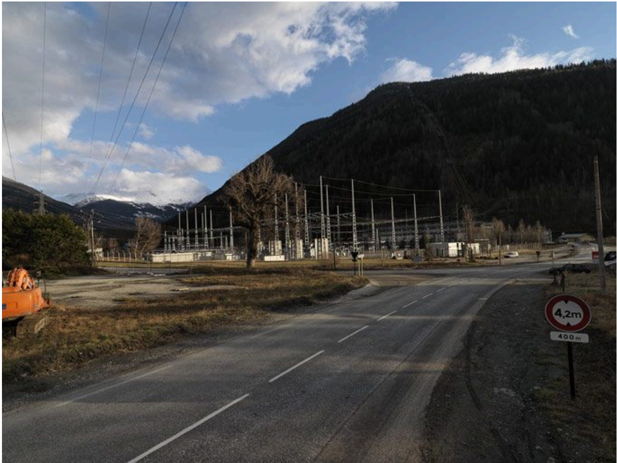
Le poste de transformation électrique et les conduites forcées de la centrale hydroélectrique de Malgovert
