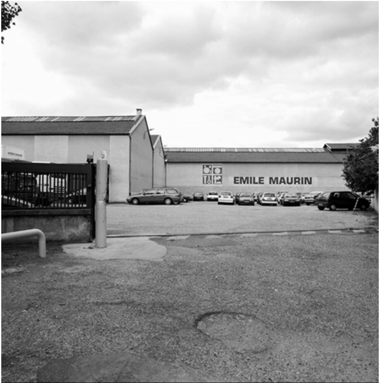
Vue nord entrée livraison
