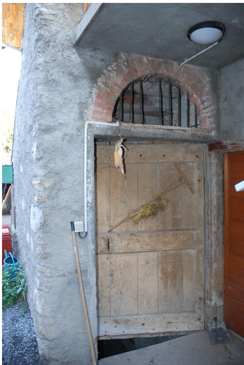
Cellier viticole, dit sarto, puis ferme (2018 E3 860, 861). Porte du local sous l'escalier.
