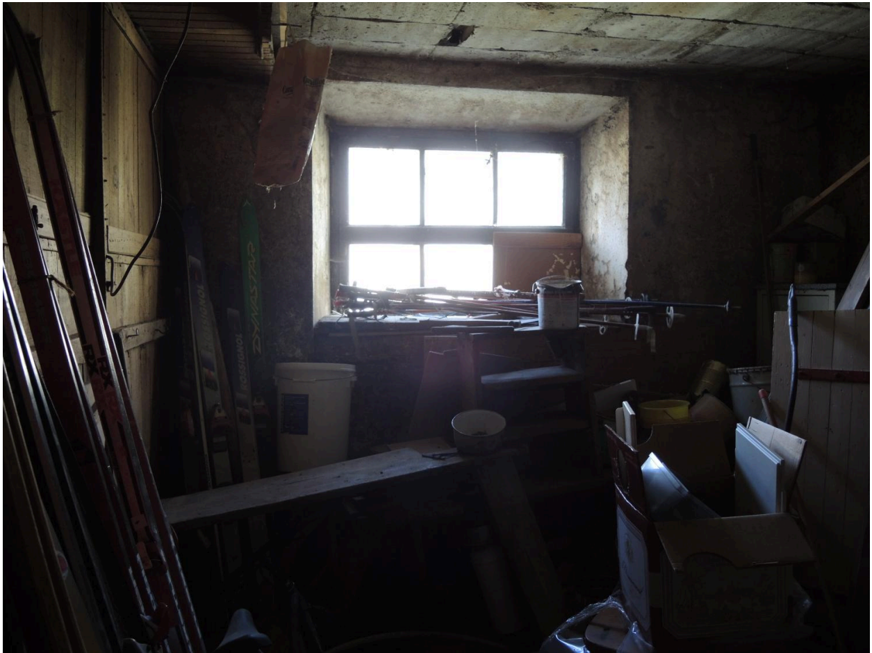
Fenêtre ancienne établie au rez-de-chaussée
