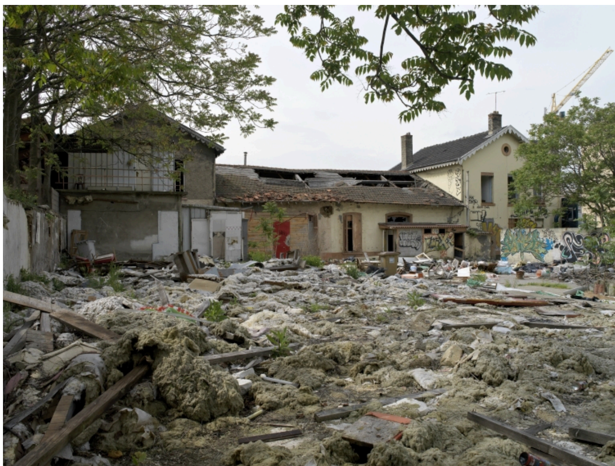
Vue générale depuis la cour située au nord ; au premier plan, les vestiges des ateliers brûlés
