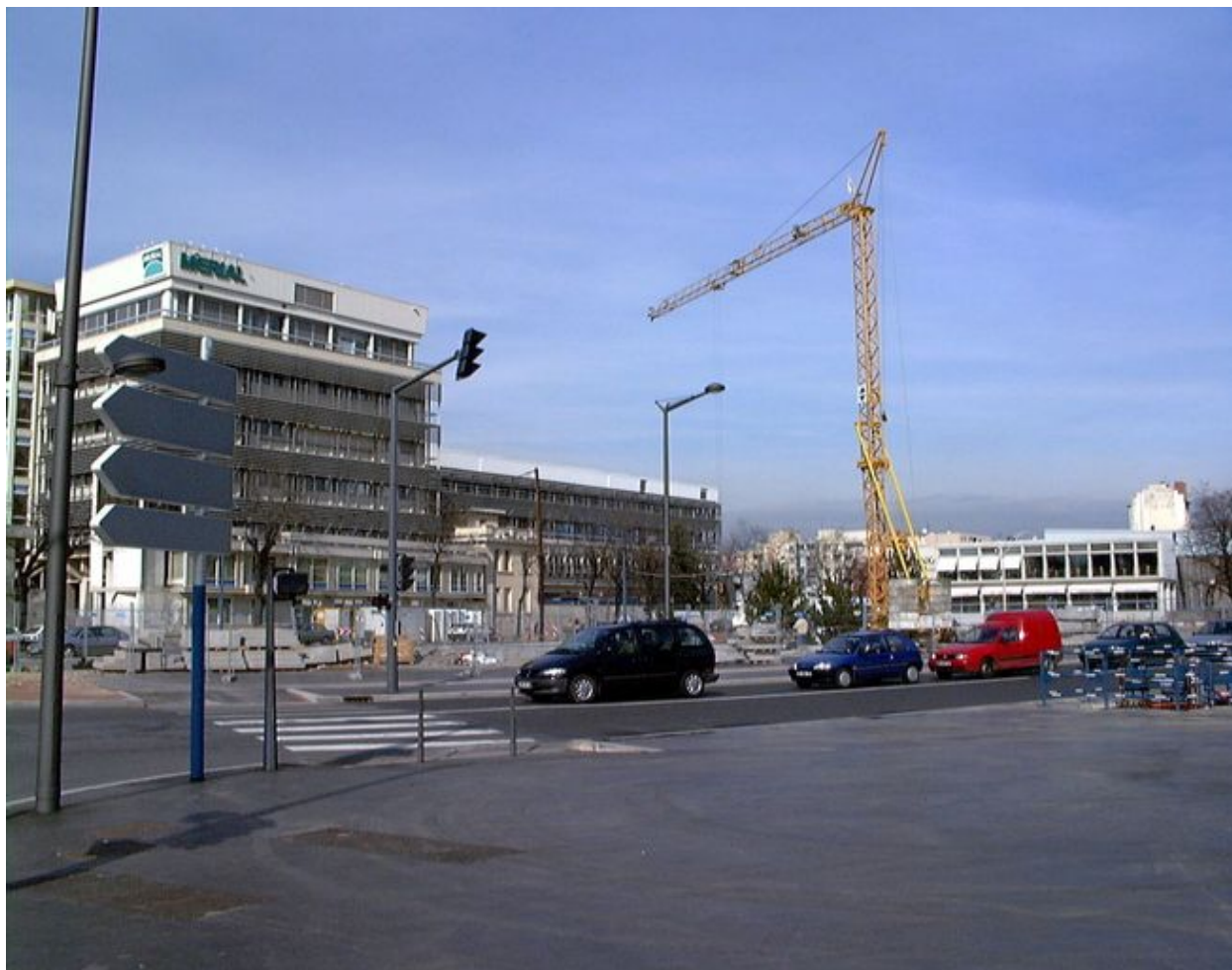
Le square en chantier (3 mars 2000)
