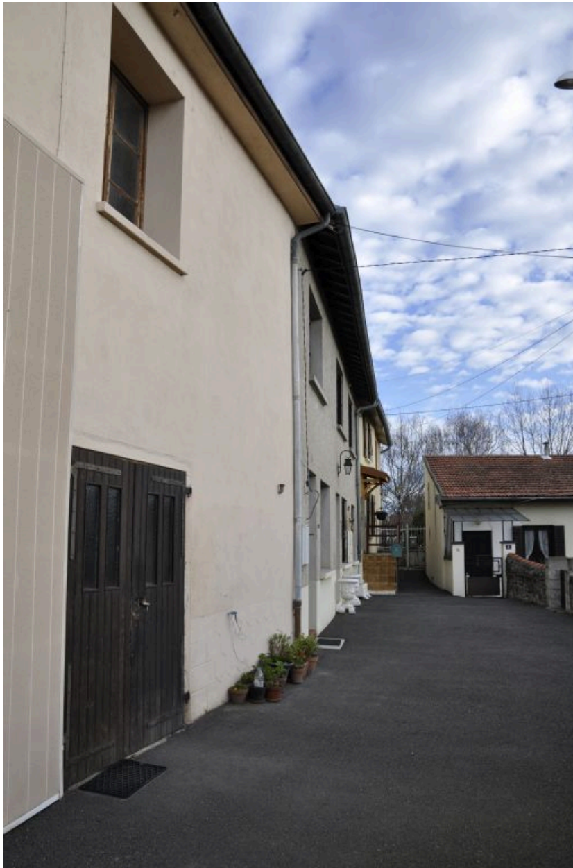
1986 AE, impasse du Bout du Monde. Vue d'ensemble depuis l'ouest.
